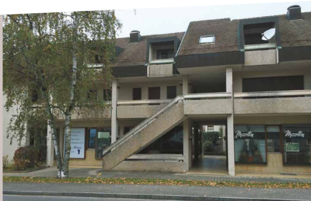
Route d'Hermance 105 avant la rénovation
